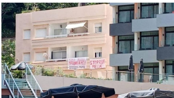
Los vecinos llevan meses reclamando medidas que rebajen el nivel de ruido de las máquinas de refrigeración del establecimiento hotelero / Vecinos contra el ruido del Meliá
